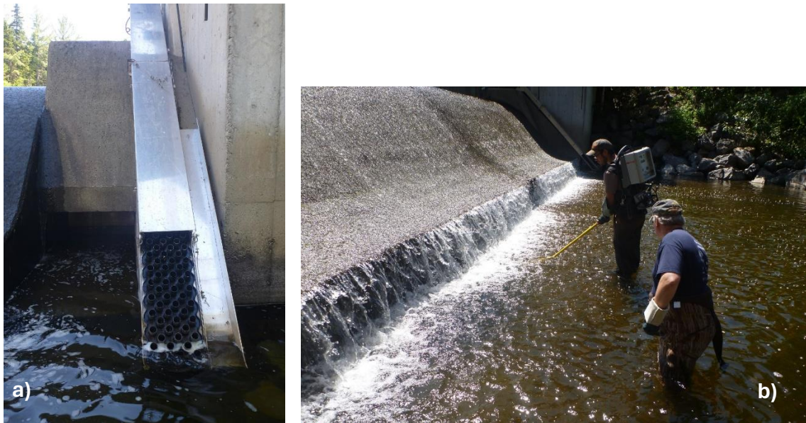
Image 6. a) Passe migratoire; b) barrage de la prise d'eau potable de la ville de Saint-Pascal.
